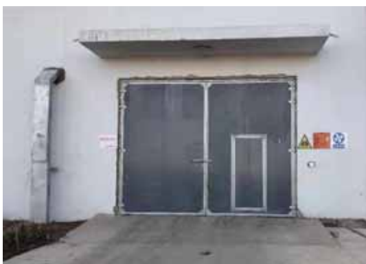
飞灰暂存间入口
