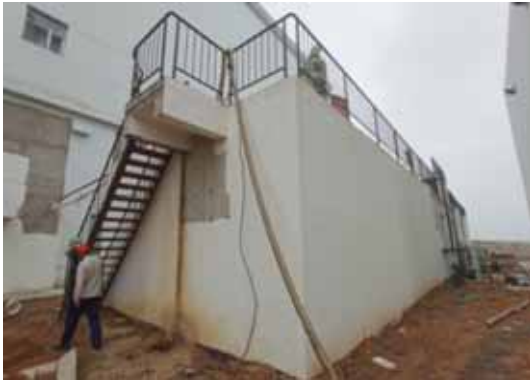
沉砂池和调节池
