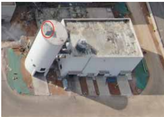
灰库布袋除尘器
