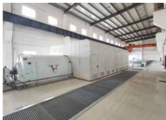
汽轮机、发电机隔声减震
