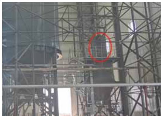
活性炭仓顶布袋除尘器
