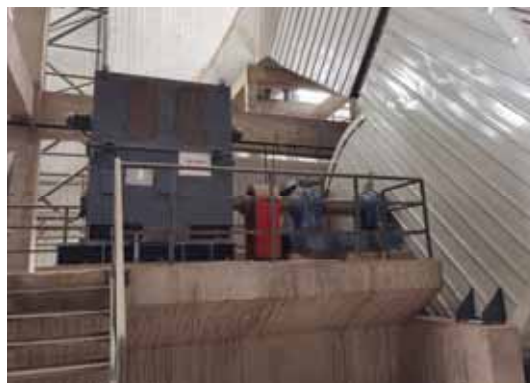
引风机室内安装隔声
