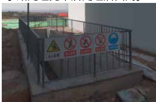
氨水间事故池
