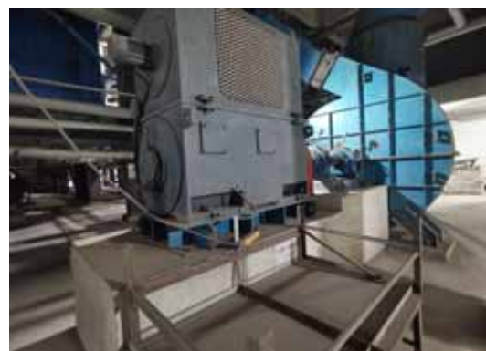
一次风机室内安装隔声
