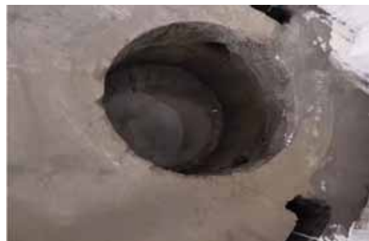
废机油库事故池
