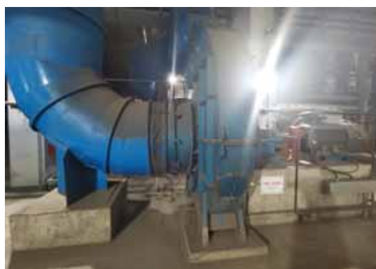
二次风机室内安装
