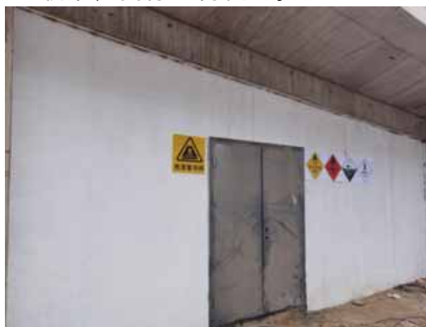
废油暂存库入口
