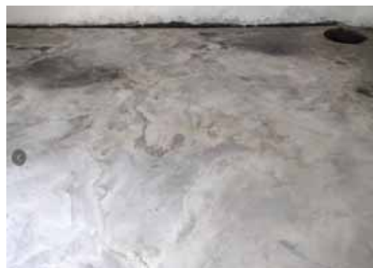
废机油库防渗
